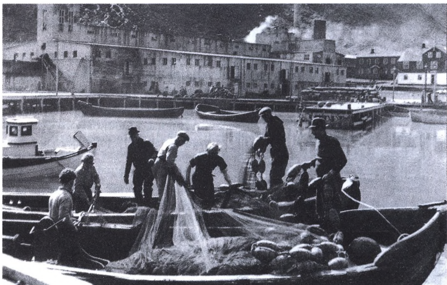
Fig. 11. Sildeoliefabrik og sildestation i Djúpavík, ca. 1945.
